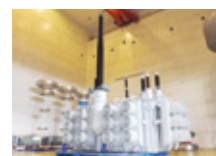
1000kV交流变压器 1000kV AC transformer
