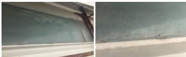
天窗接缝部位部分锈蚀
