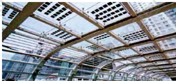
BIPV方式光伏发电
