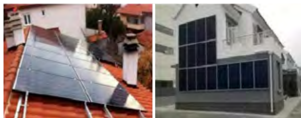
BAPV方式光伏发电(左:屋面 右:墙面) (4)
