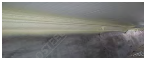
室内搭接区保温、贼风处理(聚氨酯喷涂)
