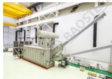
±800kV换流变压器 ±800kV Converter transformer
