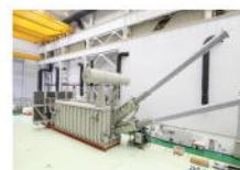
±800kV直流变压器 ±800kV DC transformer
