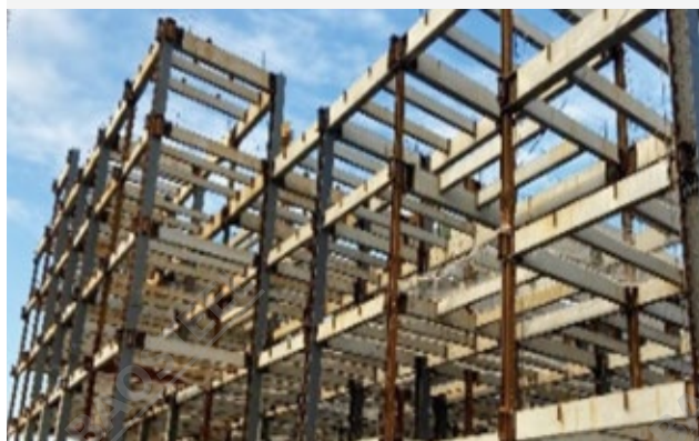
上海世博园双子山项目地上主体结构
